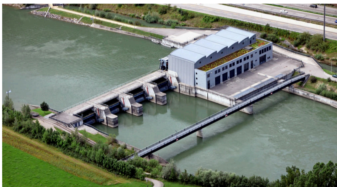
Die Fussgängerbrücke bleibt für fast einen Monat von 7:30 bis 16:30 Uhr gesperrt.
